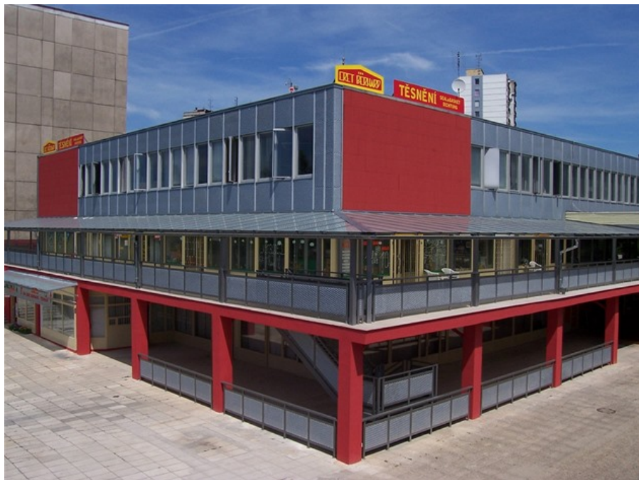
Kvalitní těsnění vyžaduje precizní zpracování | foto: EBK ERET BERNARD
